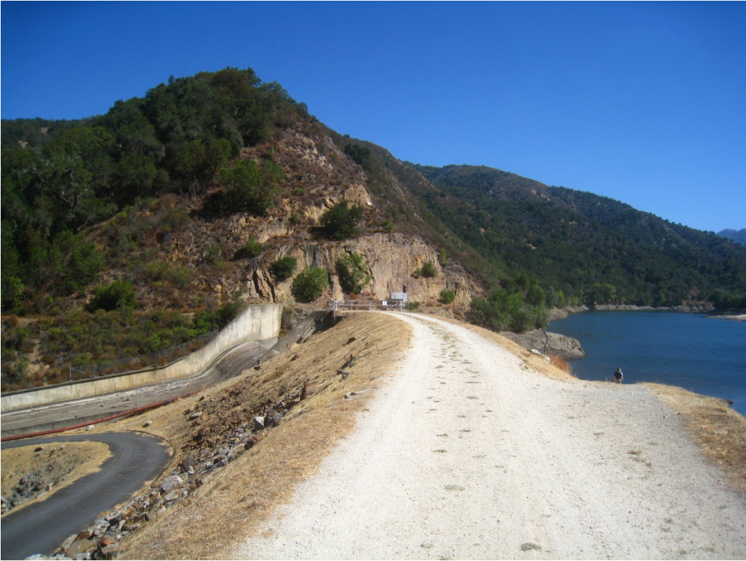
Los Padres Dam ramp area (September 14, 2012)
